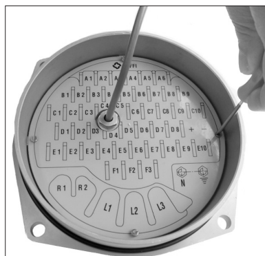
Figura 54. Remover a Etiqueta de Indicação do Terminal
