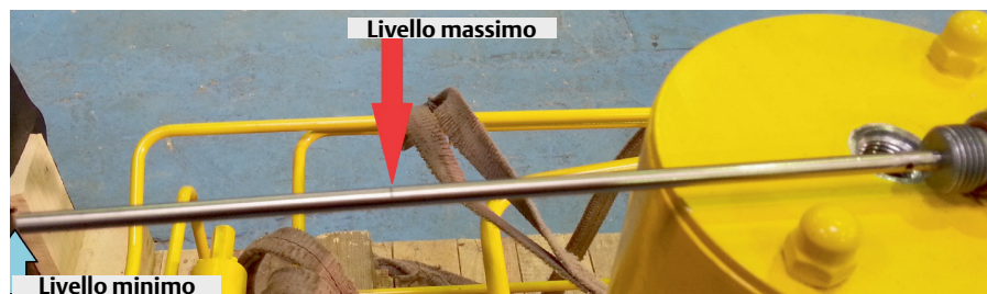
Figura 37. Asta di misurazione del livello
